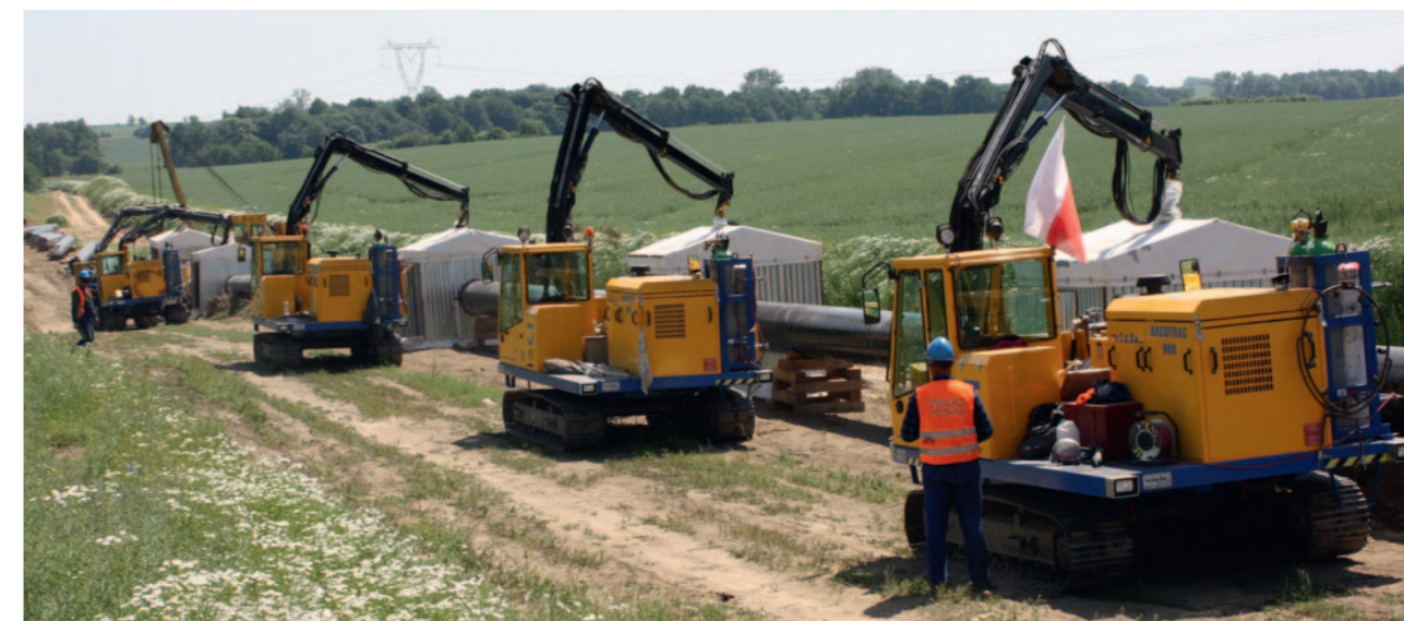
Gasleiding in aanbouw van Szczecin naar Lwówek (Polen)
